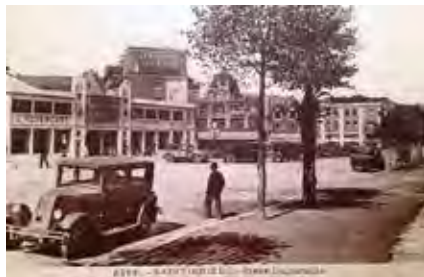
Le Central Garage, place Duguesclin à Saint-Brieuc.
