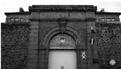
Maison d'arrêt de Saint-Brieuc construite en 1903.
