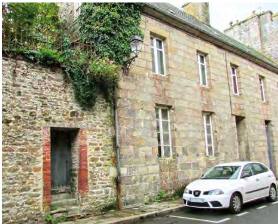
Maison dite de la « Palestine », rue au Lin. Le mur percé d'une porte n'existait pas à l'époque, il a été construit pour obturer l'accès à la cour intérieure.
