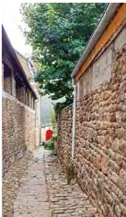
L'allée aménagée pour l'accueil des gendarmes dans la Halle, dont les revêtements sont d'époque.
