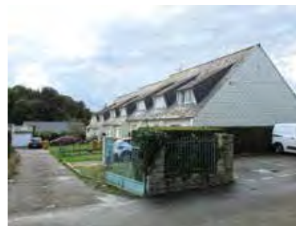
Les logements de la gendarmerie rue de Saint-Eutrope.
