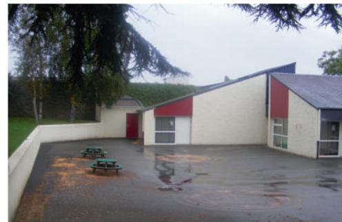
La plus grosse partie des travaux a été le remplacement des huisseries de l'école : les baies vitrées en bois étaient usagées et leur remplacement entre dans une démarche d'économie d'énergie puisqu'il va nous permettre de réduire la facture de chauffage dès l'hiver prochain. Ces travaux ont réalisés par l'entreprise Etiemble et s'élèvent à 74 000€.
