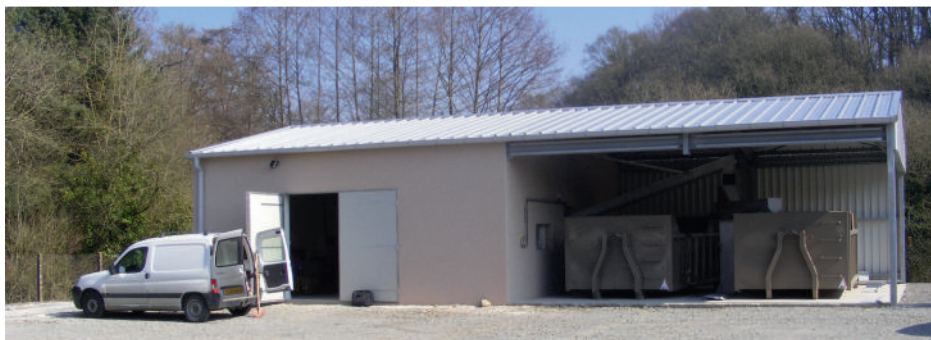
Le local abritant la centrifugeuse de la station d'épuration
