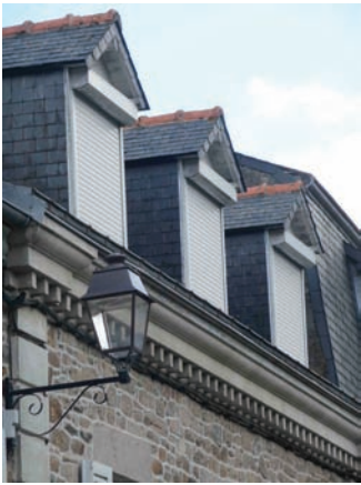
Menuiseries et volets roulants en pvc inadaptés à la qualité du bâti
