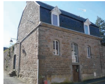
Toiture à la mansard, raccord en ardoise
