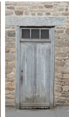
Porte à imposte vitrée (manque le panneau losangé en partie basse)
