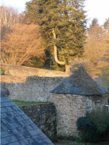
Structures de jardins vus depuis l'arrière des maisons rue Rochonen
