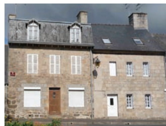
Toiture à la mansart avec membron de zinc
