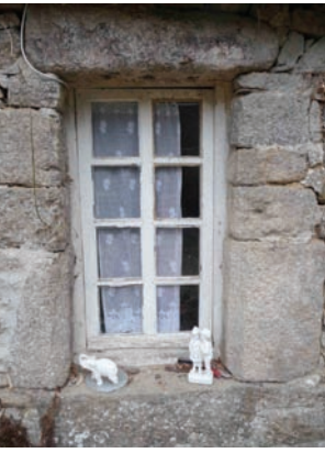
baie de l'habitation
