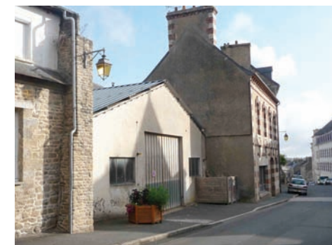
Immeuble en rupture avec la continuité urbaine Peut être remplacé
