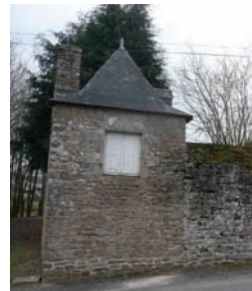
Toiture à croupes
