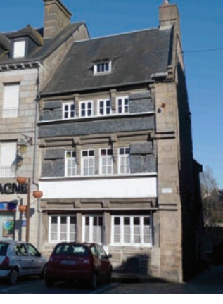
Pan de bois recouvert d’un essentage d’ardoises
