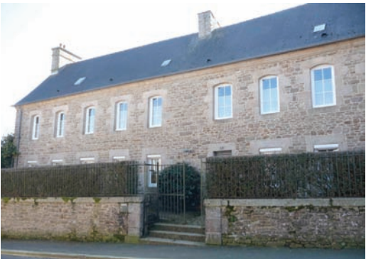
Menuiseries et volets roulants en pvc inadaptés à la qualité du bâti
