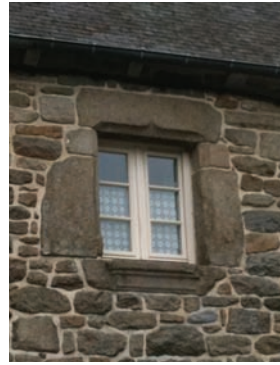
Baies à linteau en accolade et appui mouluré
