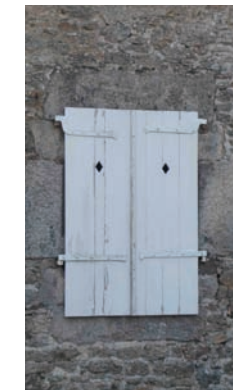
Contrevents plein et ajouré avec ses pentures à moustaches d’origine
