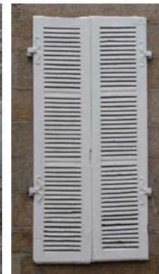
Contrevents plein et ajouré avec ses pentures à moustaches d’origine
