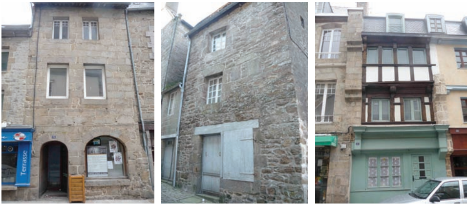
Anciennes échoppes compatibles avec la structure du bâti
