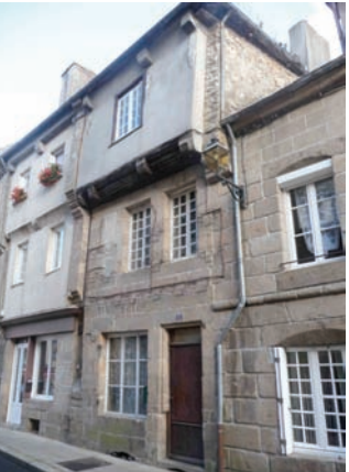
Pan de bois sur deux niveaux de granit
