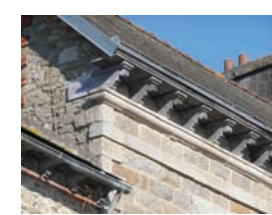
Débord de toiture à modillons de bois
