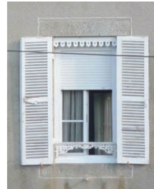
Le lambrequin masque le coffre de volet roulant à lamelles bois
