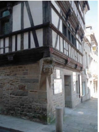
Soubassement en granit
