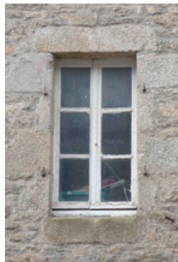
Menuiseries à 6 carreaux
