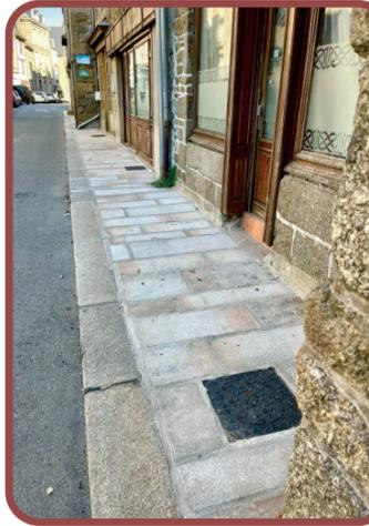
Le second chantier est localisé sur l'avenue du Général de Gaulle, en haut du Champ de Foire. Un enrobé hydrodécapé vient d'être posé en lieu et place d'un sablé. Ce chantier est la première étape d'un projet plus global, visant à faciliter et à sécuriser les déplacements piétonniers le long de l'avenue en créant des continuités de cheminement.
